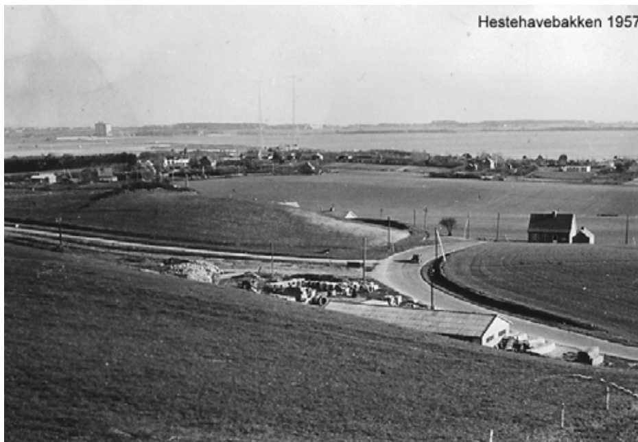
Hestehavebakken omkring 1957. Bemærk cementstøberiet i forgrunden ved indkørslen til Brandsbjerg og i baggrunden Asnæsværket, der knap er færdigt.
